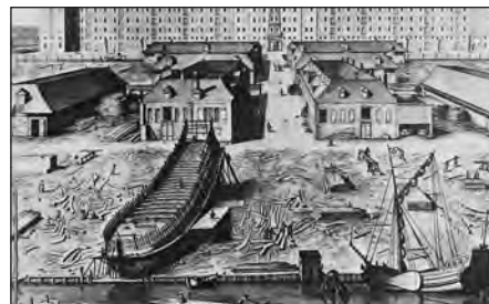
Будівництво корабля на верфі Амстердама. Гравюра
