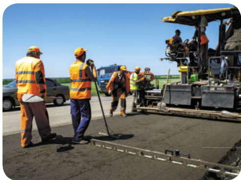
Ремонт дорожнього полотна
